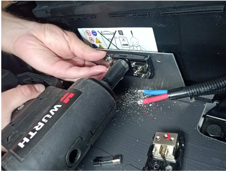
Abb. 8: Vernieten des neuen Sicherungshalters
