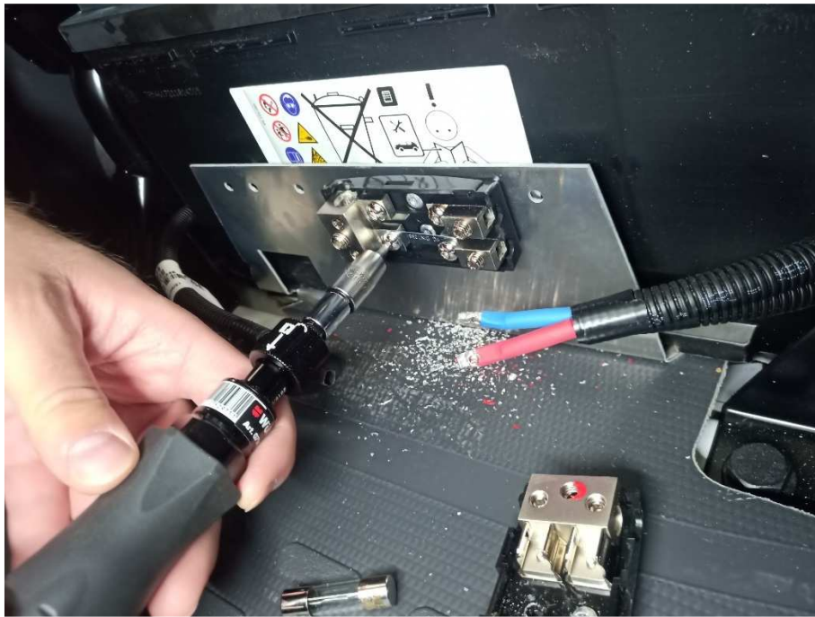
Abb. 9: Befestigen der unteren Blechbandsicherung
