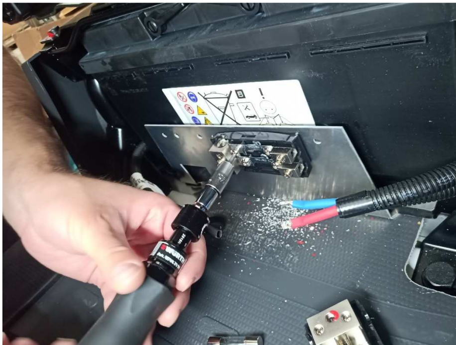
Abb. 10: Befestigen der oberen Blechbandsicherung
