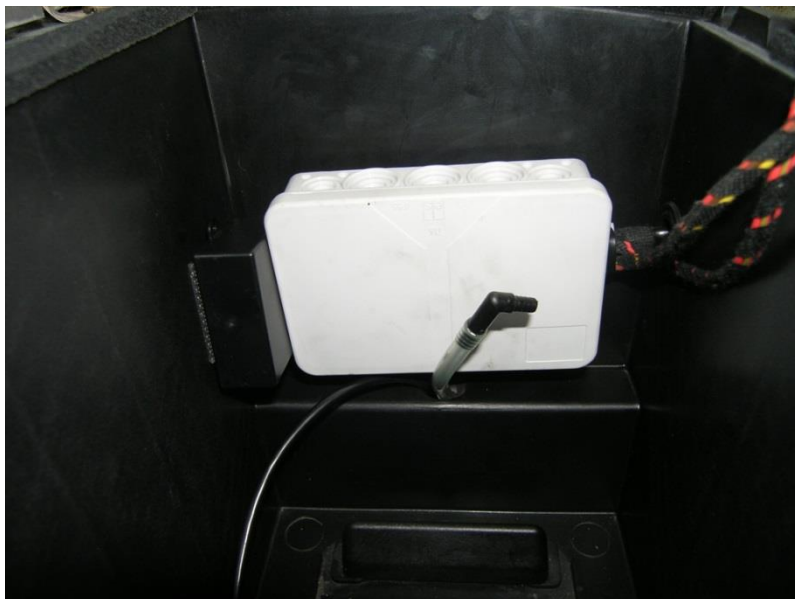
Abbildung 38: Befestigung des Relay Schaltkastens und des Dragon Winch Receivers im Batteriekasten
