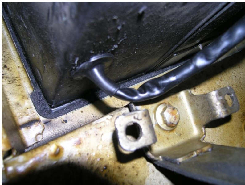
Abbildung 41: Durchführung des Kabelbundes aus dem Batteriekasten
