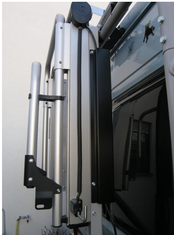
Abbildung 33: Verlegung und Befestigung des E-Lift Anschlusskabels
