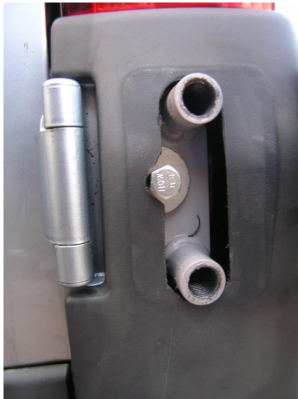
Abbildung 17: Einsatz und Verschrauben der neuen Befestigungsplatte
