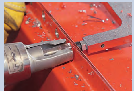
Mit dem Schälbohrer trennt Thomas Geis nur die oberste Blechlage auf. Dann lässt sich...
