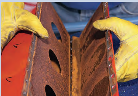
...der „Innenschweller“ abnehmen. Erste Einblicke zeigen: jede Menge Rost
